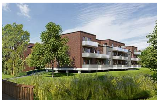
So wird die Anlage nach der Fertigstellung aussehen. Das vordere Haus nahe dem Forellenbach ist auf Betonpfählen gebaut.
