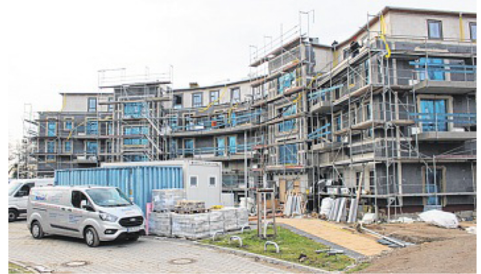
Ein Blick auf die Baustelle: Aktuell laufen die Arbeiten für die Kita im Wohngebiet Alte Molkerei.
